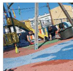
Trabajos de renovación del caucho.
