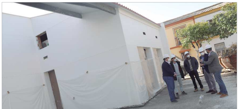
El alcalde de La Rinconada, Javier Fernández, ha visitado las obras, muy avanzadas, de la futura Casa del Flamenco.
