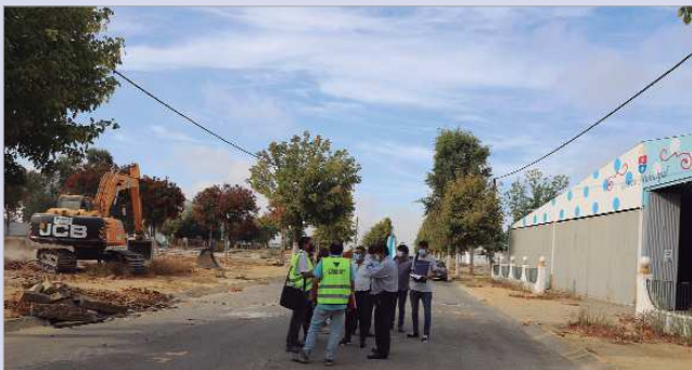
Inicio obras en el nuevo parque Santa Cruz.
