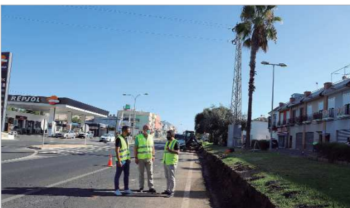
Rafael Reyes, Romero Campos y Francisco Manuel Díez al inicio de las obras.
