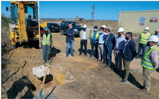
Comienzo de las obras de urbanización de Haza de la Era.
