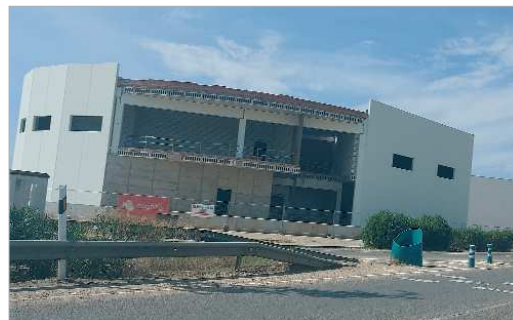
Vista de la fábrica de Arrebola, cuyas obras marchan muy avanzadas.
