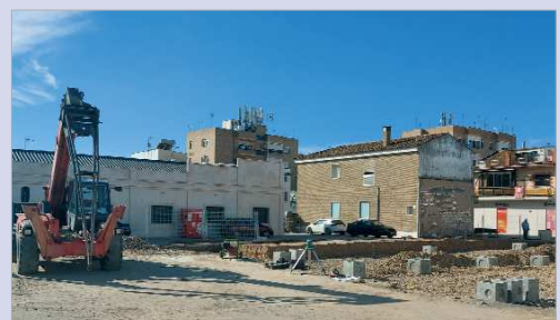
Las obras del Mercado de Abastos han comenzado.
