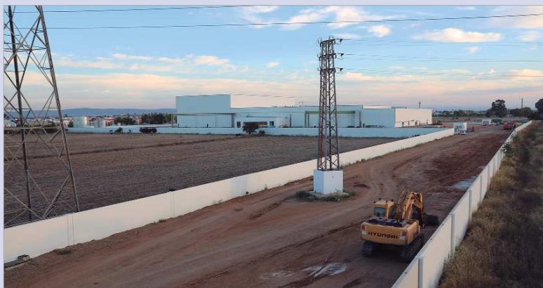
Las obras para la nueva fábrica de vasitos de arroz encara la recta final de las actuaciones.
