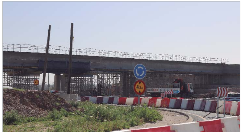
Las obras del Viaducto que cruzará en altura los suelos de La Unión avanzan según los plazos previstos.
