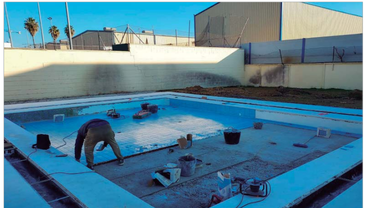
Operarios municipales han actuado en el vaso de chapoteo de la piscina Antonio Romero 'El Negro'.
