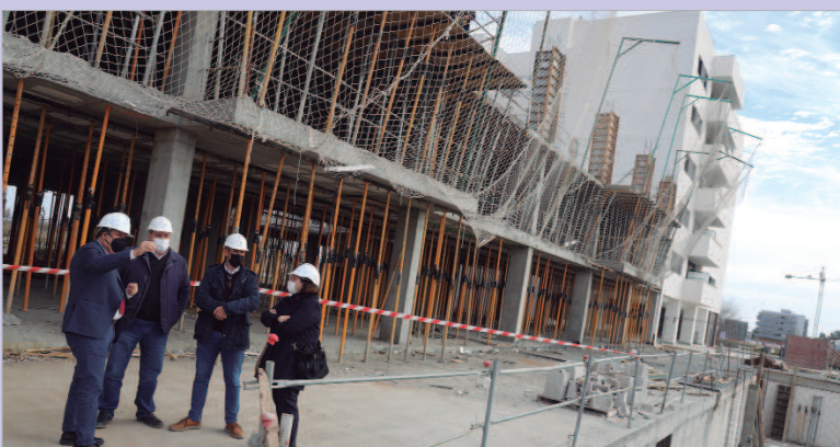
Javier Fernández en una visita reciente a las obras de la segunda fase de VPO en La Unión.
