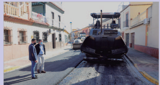
Reyes y Romero Campos, durante una reciente visita a las obras.
