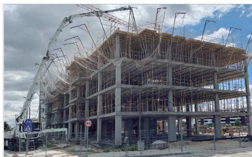
Las obras de la segunda fase de VPO avanzan según lo previsto.
