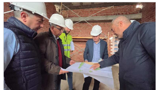
Javier Fernández y José Manuel Romero Campos visitaron las obras.
