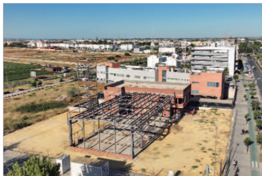
Las obras tienen un periodo de ejecución de 8 meses.
