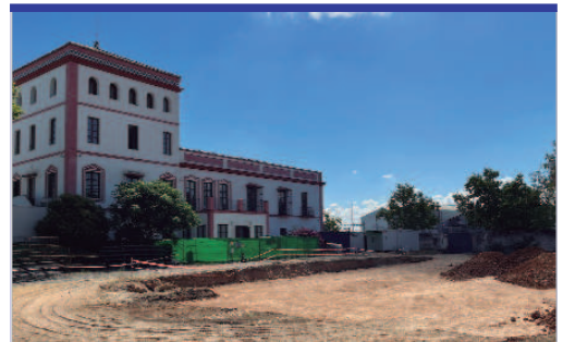
Los trabajos previos al inicio de las obras se están desarrollando.
