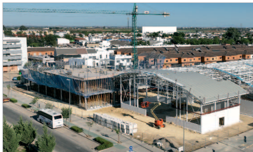
Vista aérea de los trabajos del nuevo centro FP integrado de La Rinconada.
