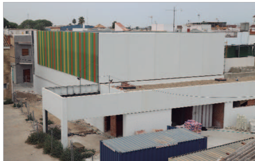
Vista de las obras del nuevo Mercado de Abastos desde 'Los Silos'.
