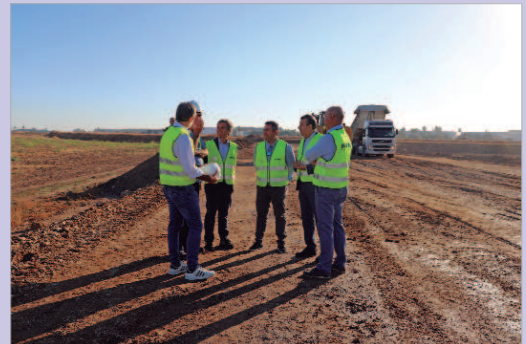
El alcalde en una visita a las obras del ramal.
