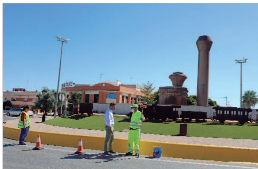
Rafael Reyes junto a un operario en una de las rotondas del municipio.
