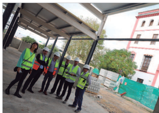
José Manuel Romero Campos visitó el centro con los responsables de obra.
