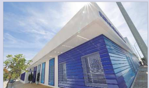
Imagen exterior del edificio.
