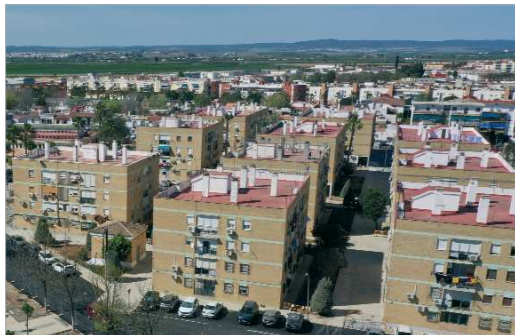
Las obras renuevan el saneamiento, pavimento, iluminación y jardines.
