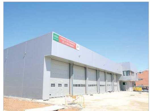
Imagen exterior del nuevo Parque de Bomberos de La Rinconada.
