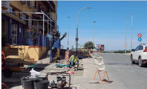
Obras en la calle Madrid para instalar los puntos de cámaras.
