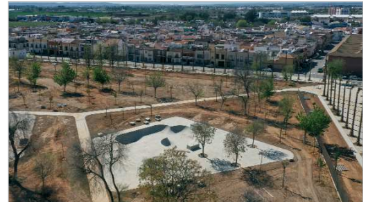
El proyecto cuenta con una inversión cercana a 1,5 millones.
