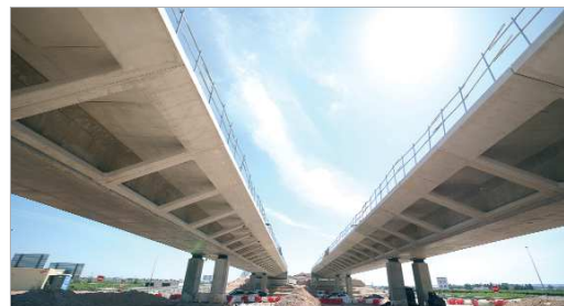
Las obras para la construcción del Viaducto marchan con retraso.
