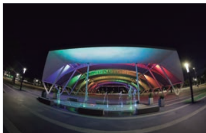
La infraestructura central de 'El Abrazo', luce con un ejemplo de iluminación.
