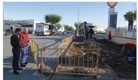
El edil de Infraestructuras Públicas en una visita a las obras.
