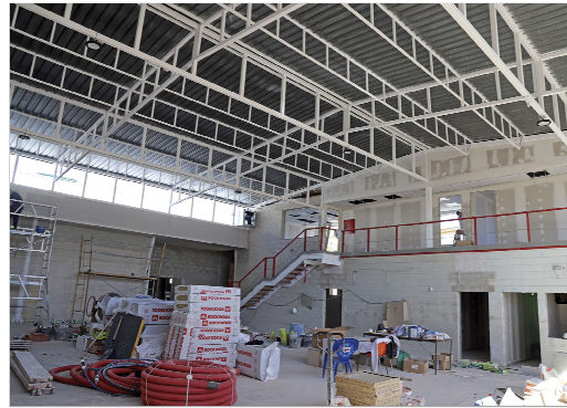
Interior del futuro pabellón.
