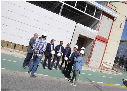
Javier Fernández visita las obras del nuevo pabellón.
