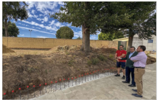
Las obras que se ejecutan en el entorno de la piscina, la ampliarán en 2025.
