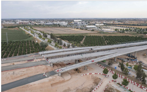
Las obras del Viaducto encaran ya la recta final de su ejecución.
