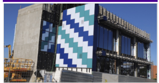
Las obras del nuevo edificio están muy avanzadas.
