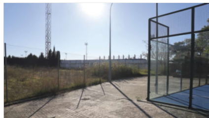
Zona en desuso por la que se ampliará el Anexo a la Piscina.
