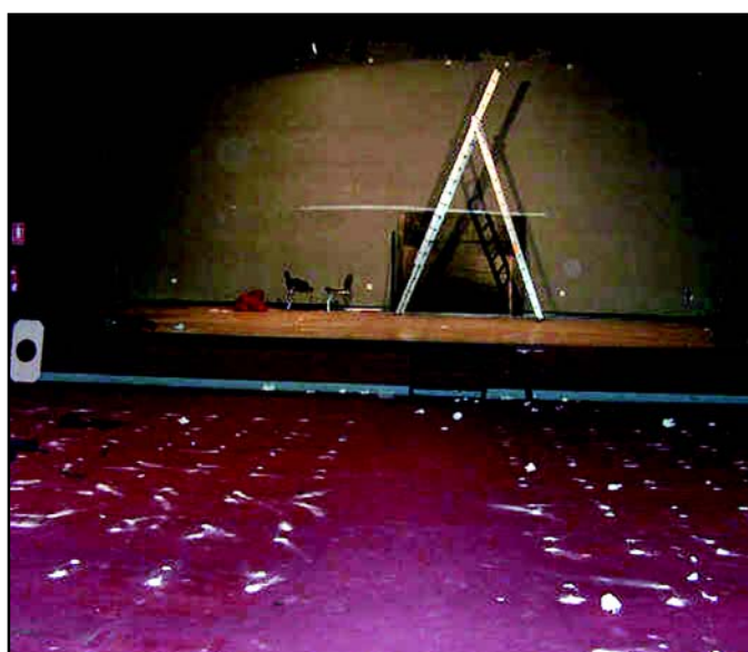
Las obras han llegado ya al patio de butacas, donde se instalará una nueva moqueta más resistente y fácil de desmontar.
