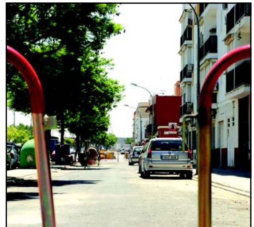
Ya se trabaja en el asfaltado, encintado, etc. de Jardín de las Delicias y su entorno.
