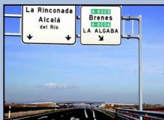
En su primera parte, de 3.860 metros de longitud, la carretera dispone de cerramientos en las márgenes, control de acceso a los laterales y enlaces a distinto nivel de intersección y acceso con otras vías. El segundo trayecto comprende 1.540 metros y adquiere condición de 'avenida urbana'.
