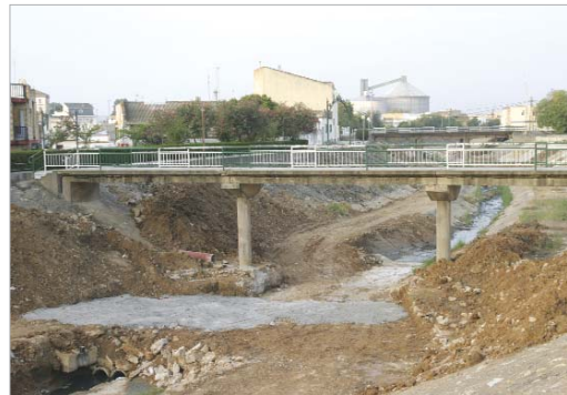
Las obras que se están ejecutando en el arroyo Almonázar.
