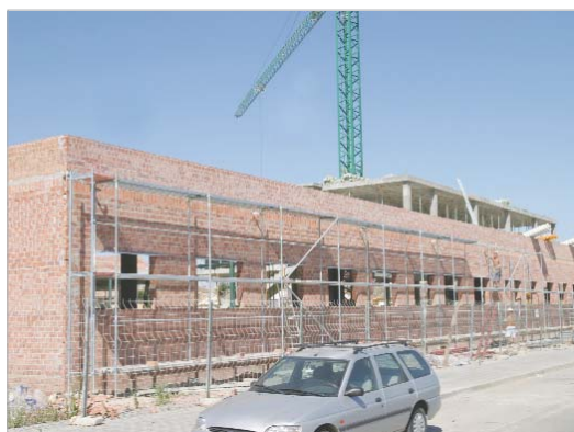
El nuevo centro de Salud, en obras.
