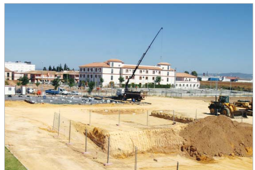
Polideportivo en construcción.
