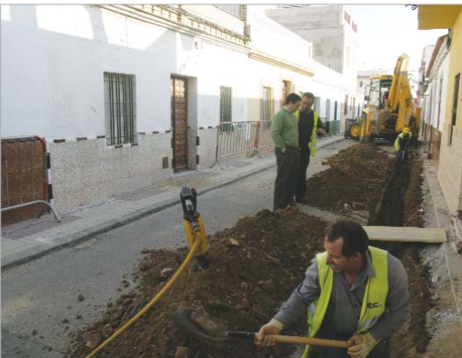
El delegado de Vía Pública supervisando las obras.
