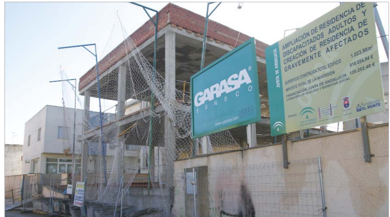
Estado de la segunda fase de las obras de la residencia.
