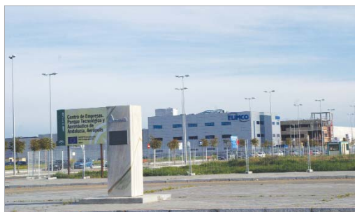
Aerópolis dispondrá de suelo para su ampliación.
