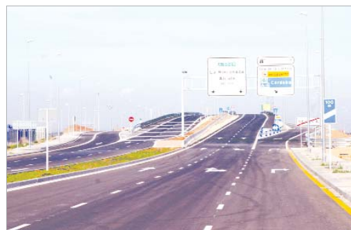
Imagen del primer tramo de la autovía.
