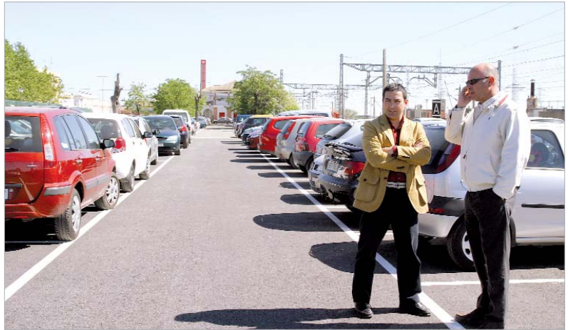
El delegado de Vía Pública, José Manuel Romero Campos, con un técnico supervisando las obras.
