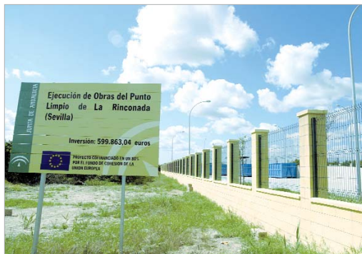
Lugar en el que va ubicado el Punto Limpio.
