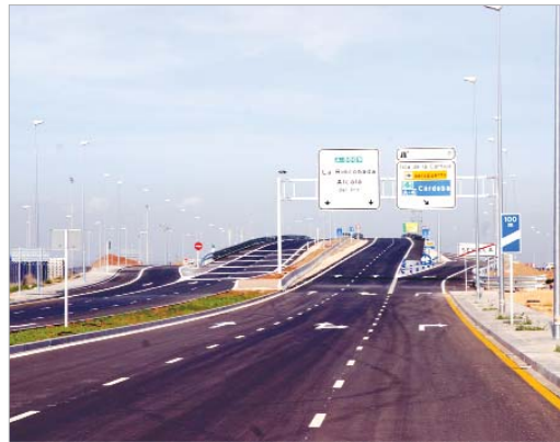
Imagen del primer tramo de la Autovía.
