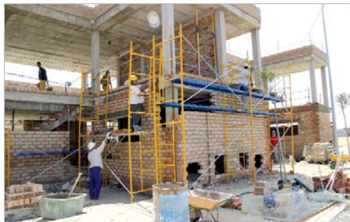
Trabajadores de la construcción.
