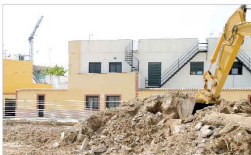
Las obras de Huerto de Benito ya han comenzado.
