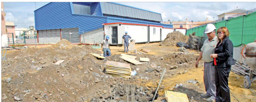
La edil de Educación, Trinidad Argota, visitó la marcha de las obras.
