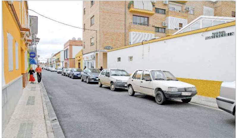
Estado en el que ha quedado la calle Justo Monteseirín, tras la finalización de las obras.
