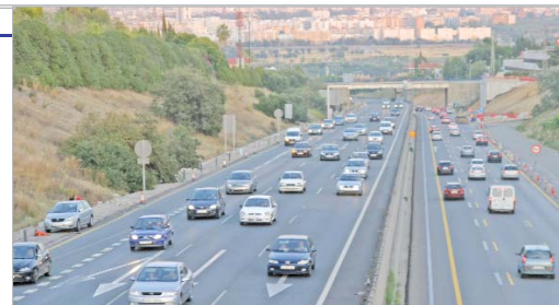
Un tramo de la A-49 a su paso por El Aljarafe.
