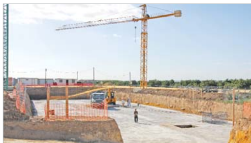
Obras en la Central Mixta de Seguridad.
