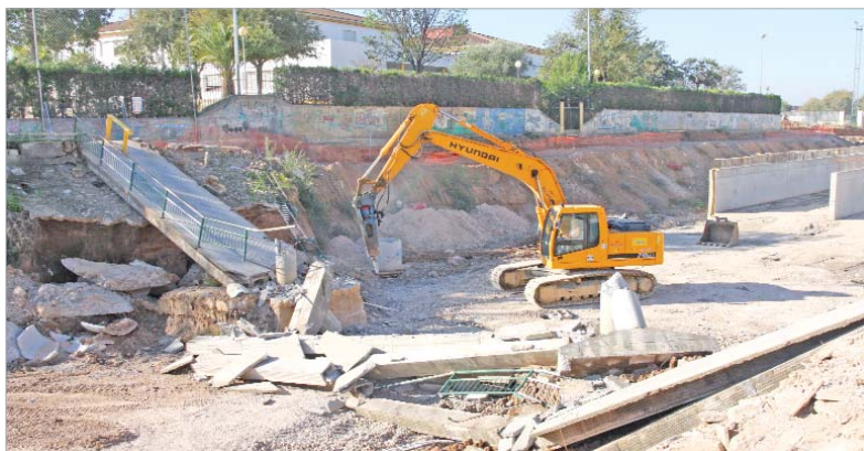
Momento en el que se llevó a cabo el derrumbe.
