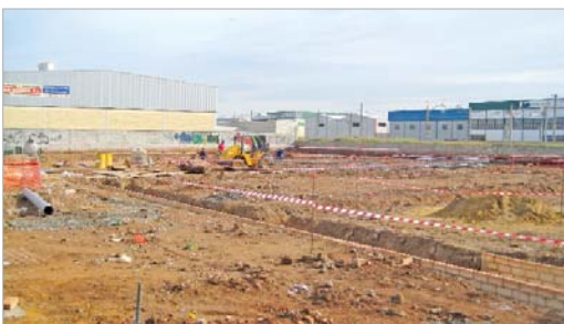
Obras en las seis naves que está construyendo el Ayuntamiento.
