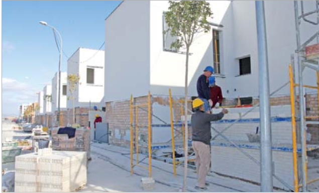
Obras en la promoción de 58 unifamiliares de Secadero de Gutiérrez.
