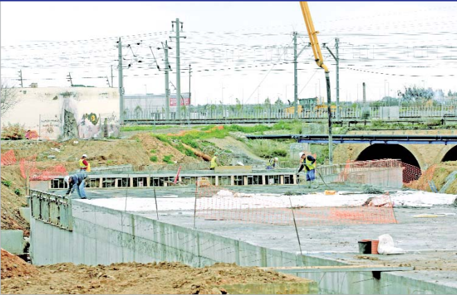
Parte final del cajón en el puente del ferrocarril.
