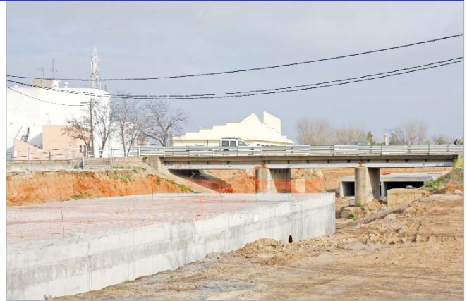
El puente de San José será demolido en breve.
