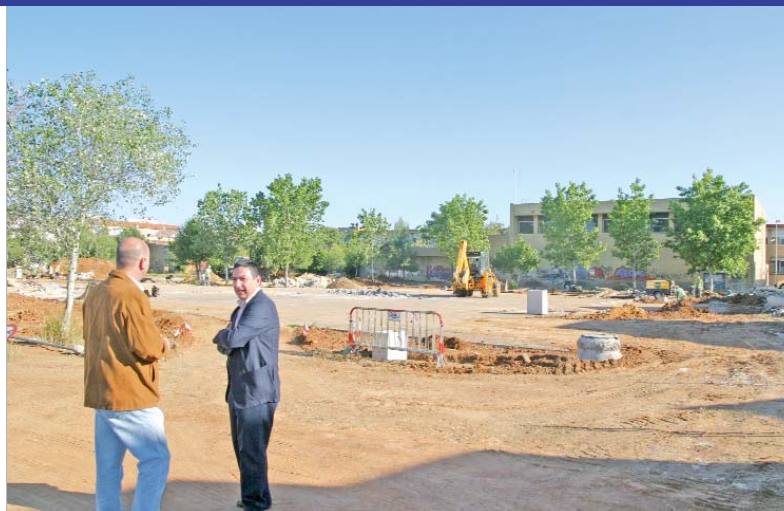
El delegado de Vía Pública, José Manuel Romero Campos, visitando el comienzo de las obras.
