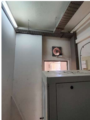
7. ANTES DE LA INSTALACIÓN
