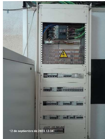
8. TRAS LA INSTALACIÓN
