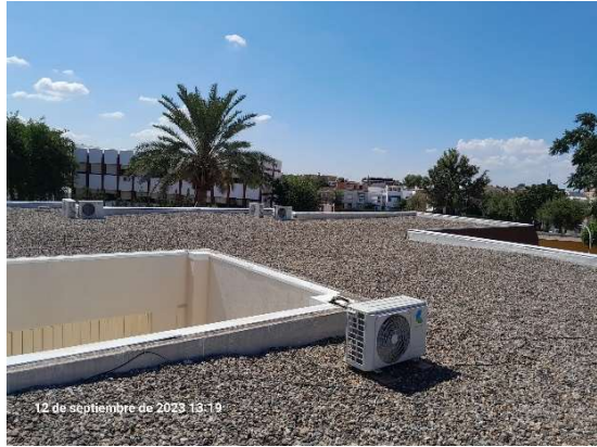
5. ANTES DE LA INSTALACIÓN
