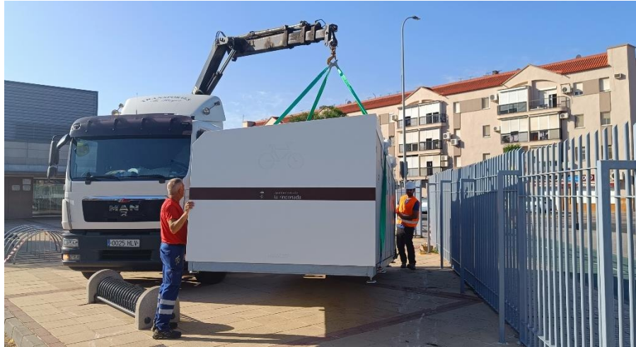
9. INSTALACIÓN DEL MÓDULO JUNTO A LA PISCINA CUBIERTA
