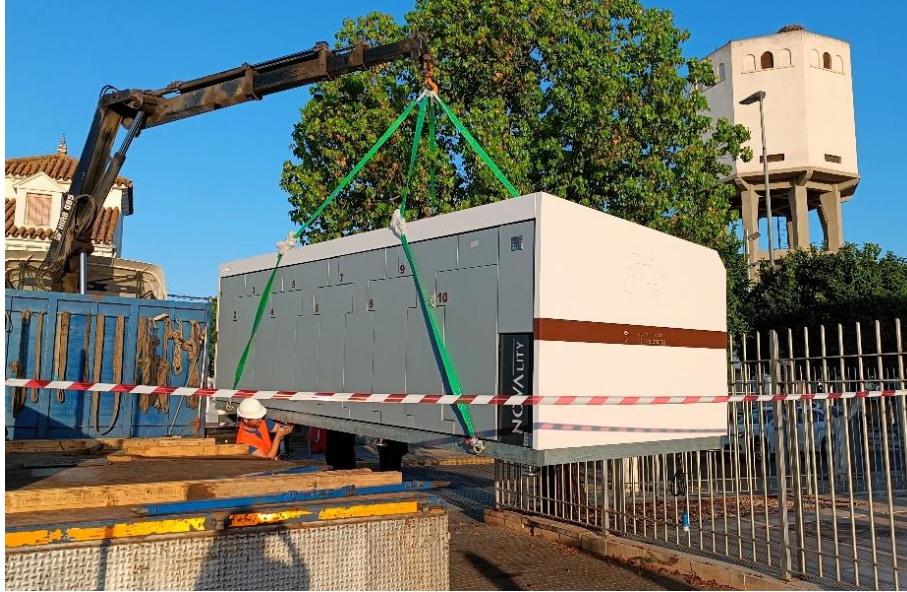
7. INSTALACIÓN DEL MÓDULO JUNTO AL AYUNTAMIENTO
