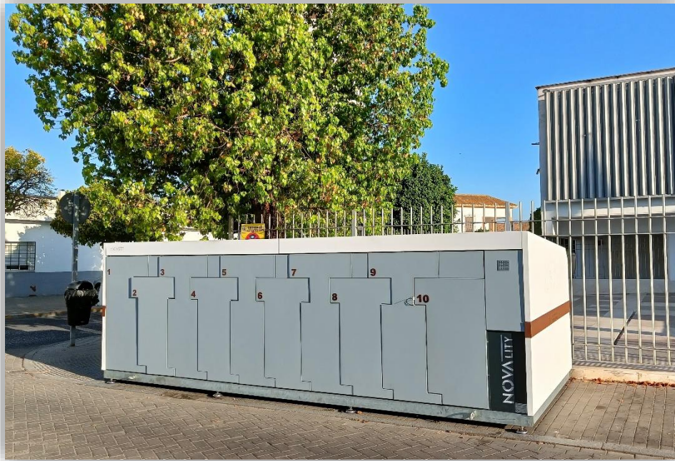
14. LOCALIZACIÓN INICIAL DEL MÓDULO JUNTO AL AYUNTAMIENTO DE LA RINCONADA
