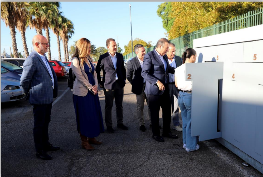
15. VISITA DEL ALCALDE, JAVIER FERNÁNDEZ, UNA REPRESENTACIÓN DEL GOBIERNO LOCAL Y EL CEO DE NOVALITY, FRANCISCO MARQUÉS, AL MÓDULO INSTALADO EN LA ESTACIÓN DE TREN
