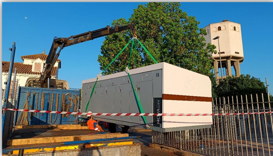
11. INSTALACIÓN DEL MÓDULO JUNTO AL AYUNTAMIENTO
